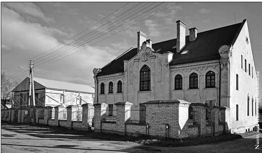
Kalvarijos sinagogų kompleksas. Vasarinė ir žieminė sinagogos.
